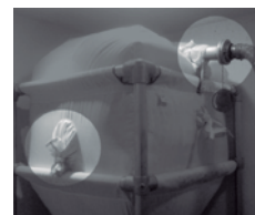
SISTEMA DE CARGA MANUAL Y CONEXIÓN STORZ.
